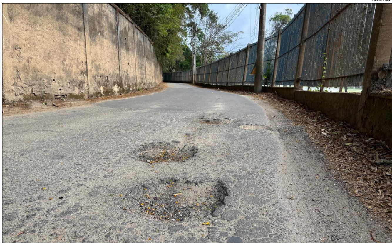
OBRAS de pavimentação e alargamento da Rua Joaquim Agante Moço serão retomadas com recursos da Caixa Econômica
