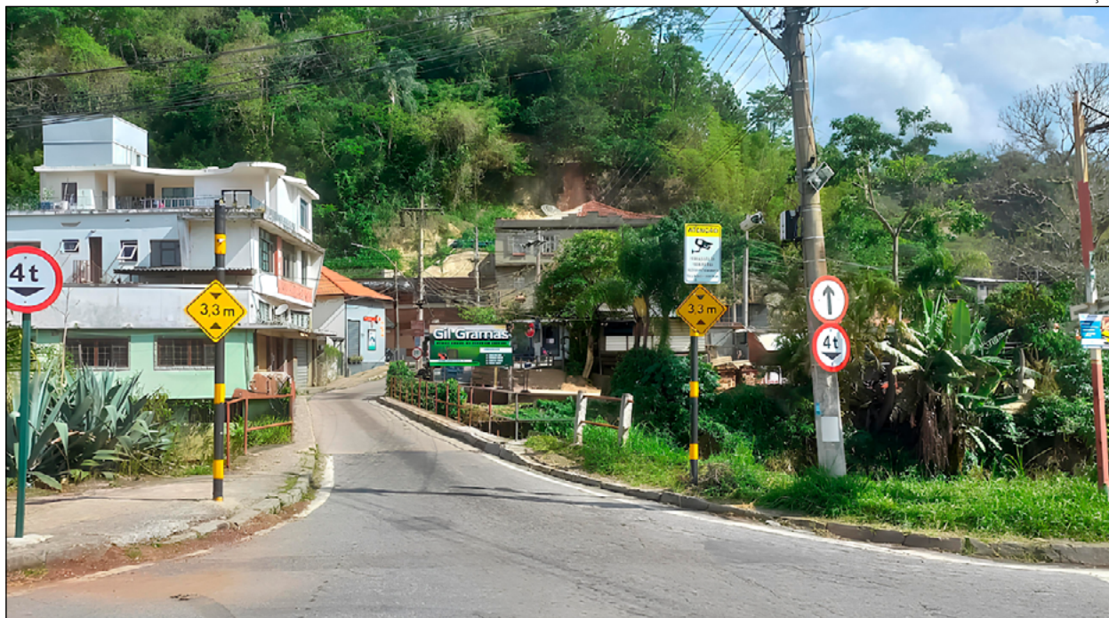
A LIMITAÇÃO de carga na ponte foi reavaliada com base em laudo técnico emitido por empresa especializada
