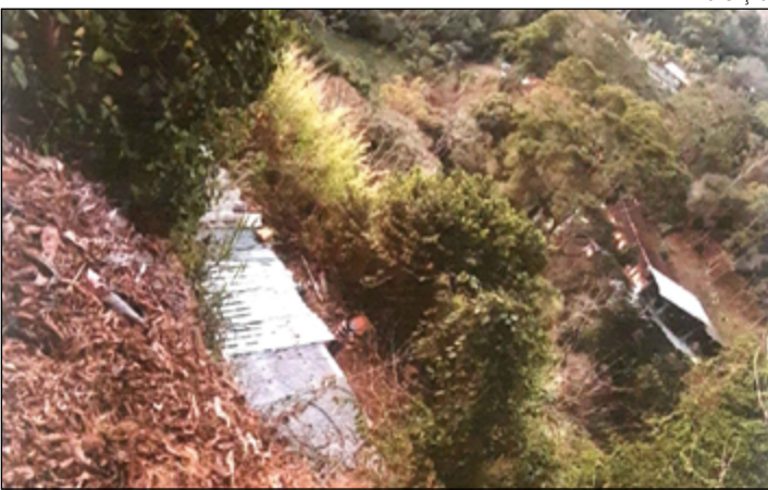
DESLIZAMENTOS de terra já ocorreram anteriormente no local
